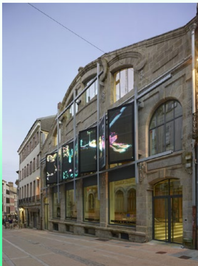
Frac-Artothèque Nouvelle-Aquitaine, Limoges 2025. ©Jakob + MacFarlane, Paris. Maîtrise d'ouvrage Région Nouvelle-Aquitaine. Photo Roland Halbe.
